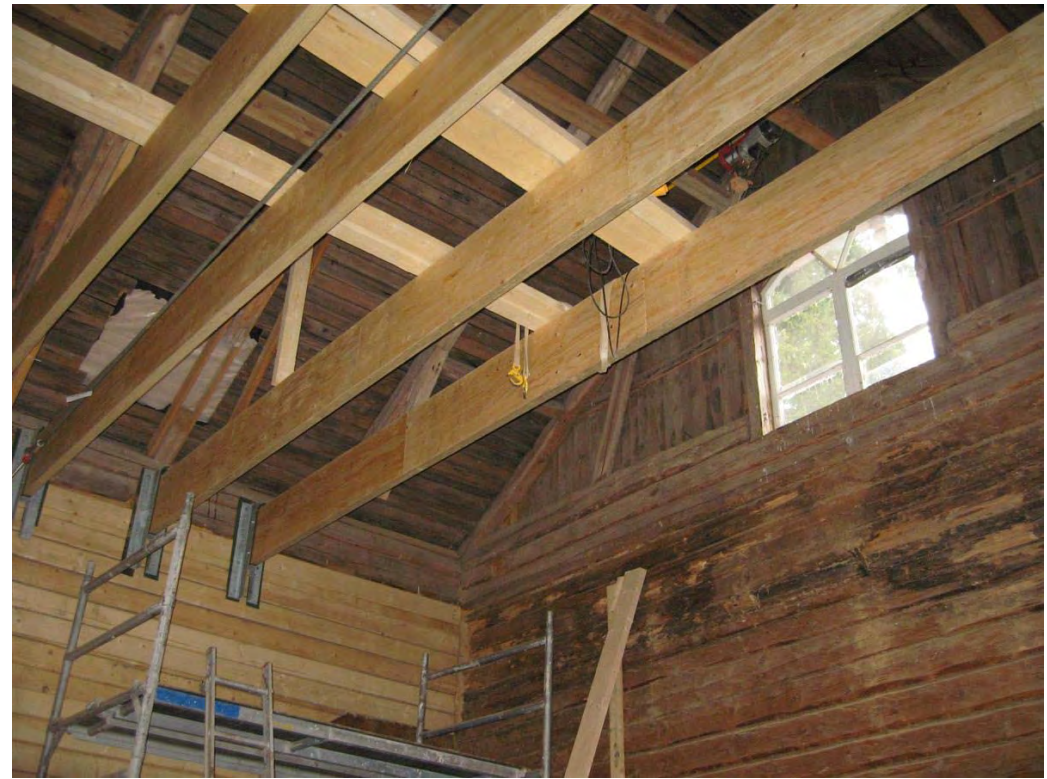
Detalj av festsalen i februari 2008. De ljusa stockarna i västra långväggen är nya och visar hur stora rötskador som funnits. Takbalkarna är förnyade och stöder nu byggnaden så, att norra gaveln kan repareras. De mörka partierna på norra gaveln visar hur fukten fått fara fram.
