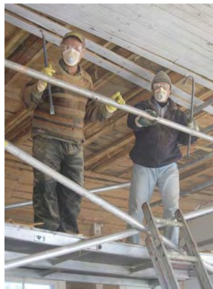
Erik Eklund och Johan Brenner ser ut som rymdmänniskor när de river ner mellantaket i ruttna träpanel i oktober 2007.
