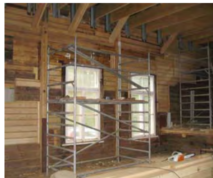
Festsalen i februari 2008. En stor mängd gamla stockar i västra långväggen har bytts ut, liksom också alla balkarna i mellantaket. Innan balkarna kunde monteras måste hela huset stagas upp med stålvajrar, för att inte väggar och tak skulle ge efter.
